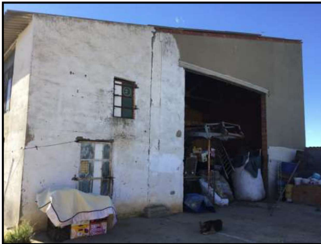
FOTOGRAFÍA EXTERIOR DE LA NAVE 3 Y DE LA PANERA-PALOMAR
