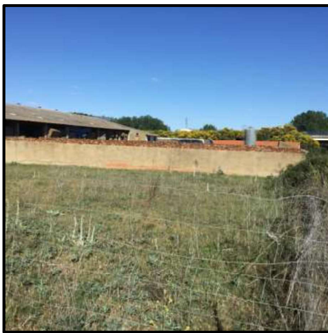
FOTOGRAFÍA 21 y 22: CERRAMIENTO EXTERIOR
