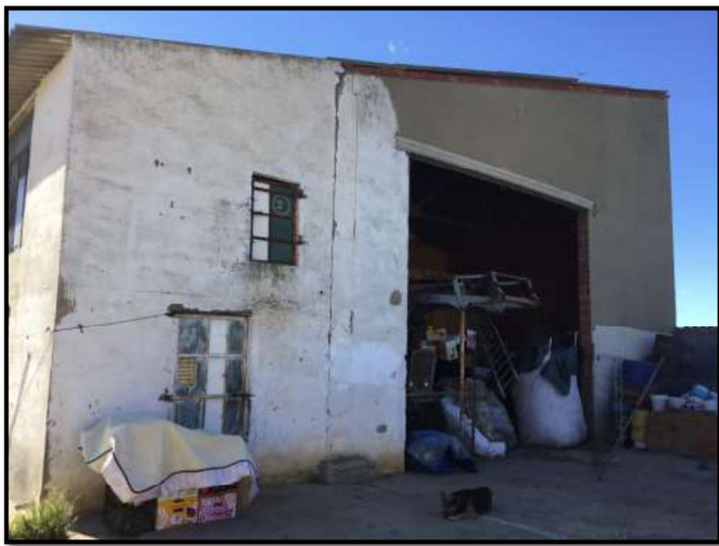
FOTOGRAFÍA 14: EXTERIOR DE LA NAVE 3 Y DE LA PANERA-PALOMAR
